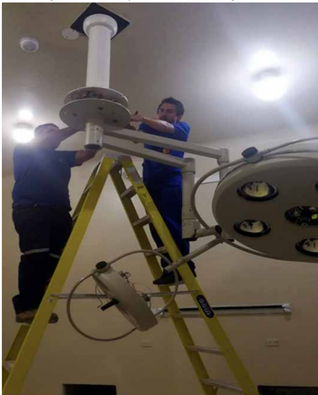
Figura 1.4 Instalación y mantenimiento de la lámpara cialítica
